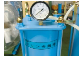
ドレン分離槽 圧力計
