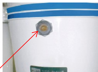
P-XAB 槽 ■上部の⑤確認窓を見てエレメントが茶褐色に汚れてきたら・・・交換 ※サビ等で赤茶色に変色する場合があります。
